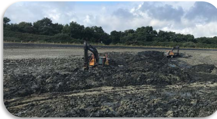
Brassage mécanique afin de favoriser le séchage
