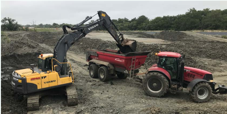
Chargement des sédiments et épandage
